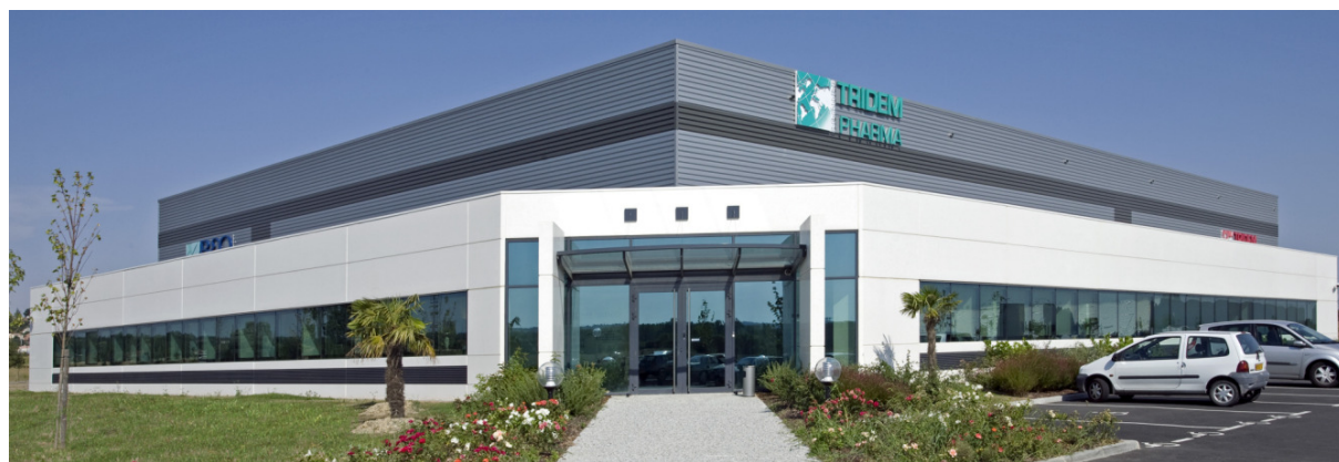
Vue du bâtiment existant
