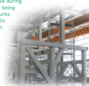
> Structure VTP en cours d'assemblage > VTP structure during assembly
